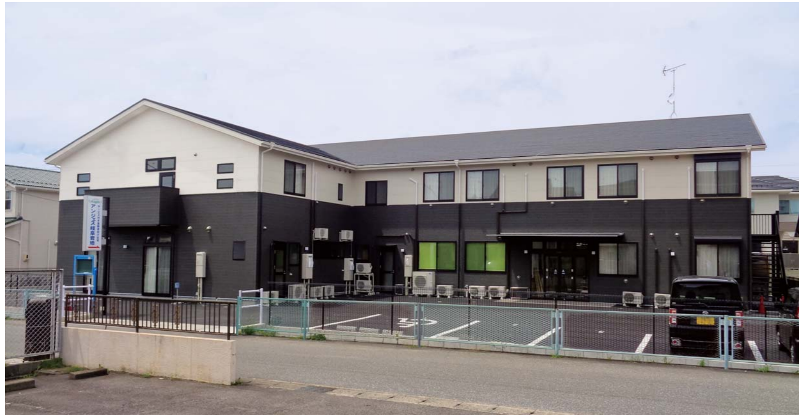
▲アンジェス岐阜岩地外観 | 土地建物は賃借です。
